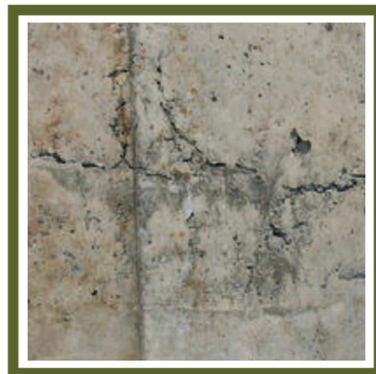
**Figure 1. Exemple de joint froid formé dans un mur de béton**
